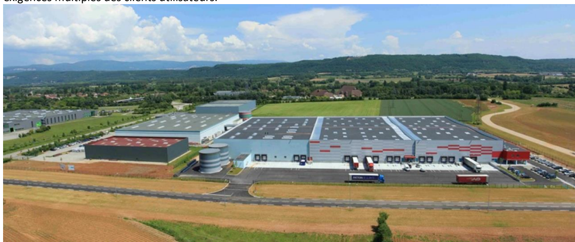
Usine et plateforme logistique de Lyon – Saint-Vulbas
